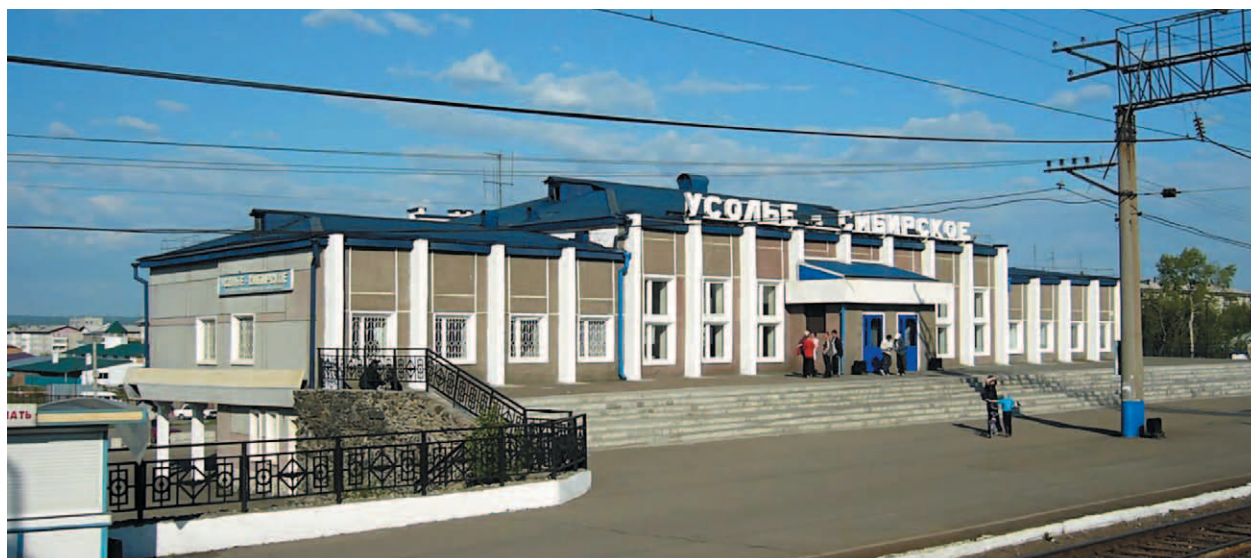
Здание железнодорожного вокзала.
