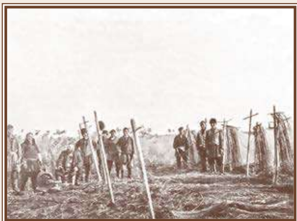
Рис. 7.8. Крюки или кресты — приспособления для сушки сетей в дельте р. Селенга (по: Кузнецов, 1909)
